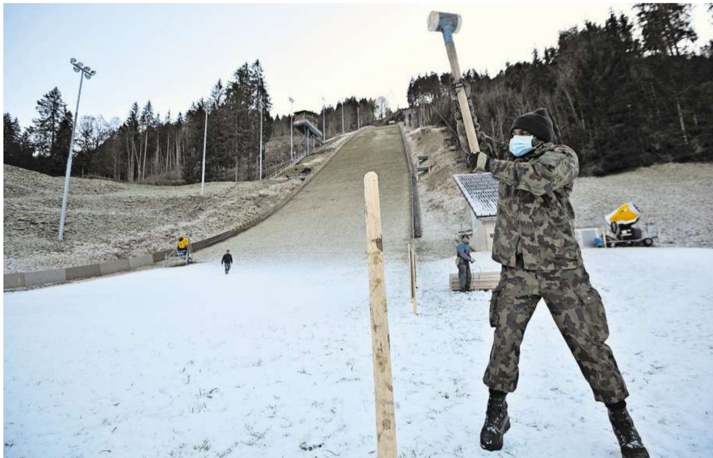
Ein Soldat während der Vorbereitungsarbeiten im Zielraum der Sprungschanze.
